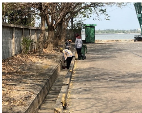
ภาพที่ 2.2-36 การขุดลอกรางระบายน้ำและบ่อเกรอะ
